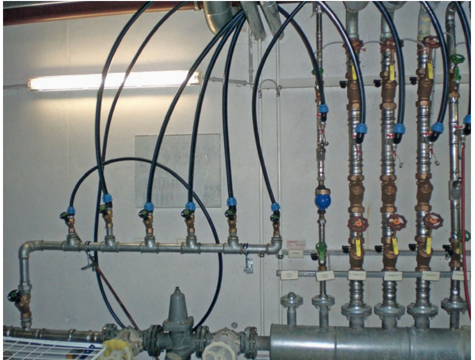
Bild 10 Provisorischer Trinkwasserverteiler für die Spülung der einzelnen Bauteile
