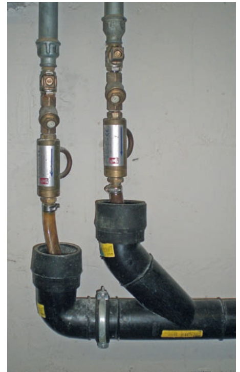
Bild 6 Verbindung zwischen Trink- und Abwassersystem
