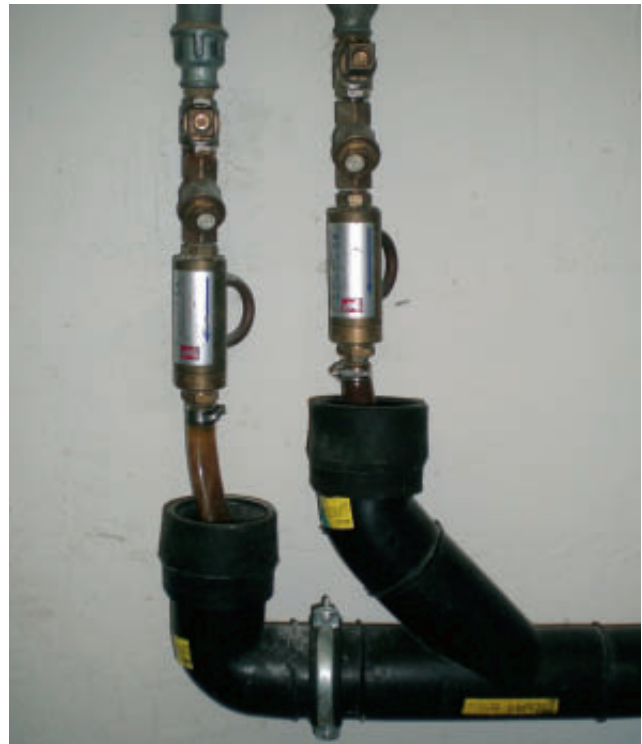
Abb. 3: Verbindung zwischen Trink- und Abwassersystem
