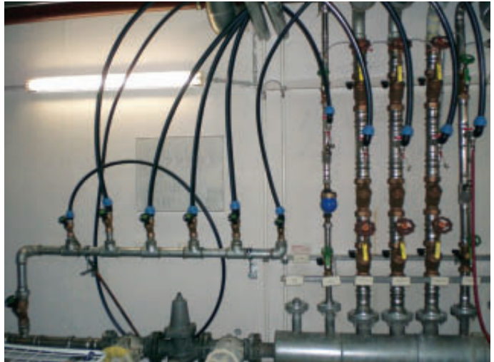
Abb. 6: Provisorischer Trinkwasserverteiler für die Spülung der einzelnen Bauteile
